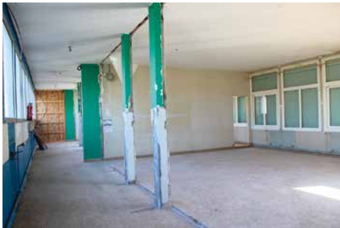
Réhabilitation de 3 salles de classe.
